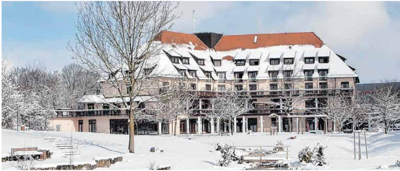
Blick vom Hotelpark auf die Südseite des Gebäudes. Der Anbau soll am linken Flügel realisiert werden.
